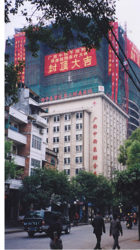
历史记忆——再用的23层医院门诊住院综合大楼封顶大吉
